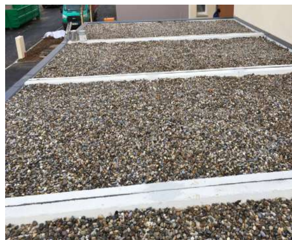
Acrotère en béton périphérique
