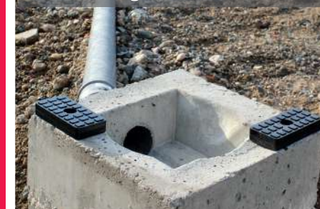
Exemple de fondation par plots avec drainage
