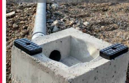
Exemple de fondation par plots avec drainage
