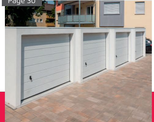
GARAGES EN BATTERIE
